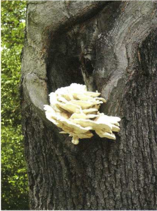
Abb. 4: Stammreifaulung an einer Alteiche mit dem Baumpilz Schwefelporling. Solche Schäden sind häufig eine Ursache für das statische Versagen eines Baumes.
